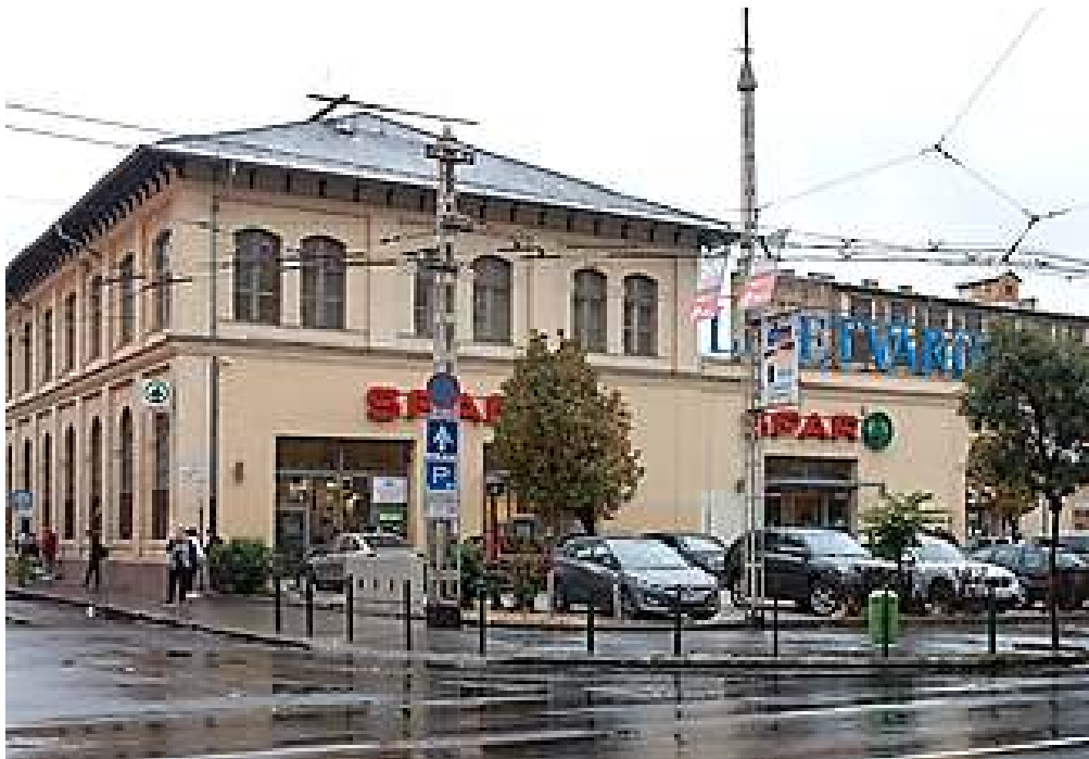
Damjanich utcai homlokzat
