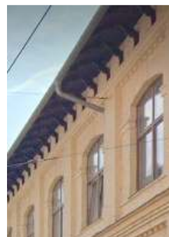
Eredeti osztású, jó ablakok a Damjanich utca felőli oldalon; másféle új ablakok a Bethlen Gábor utcai oldalon: alacsonyabban elhelyezett tokosztóval, üvegosztók nélkül, a fenti nyílászárnyak helyén egy bukószárny
