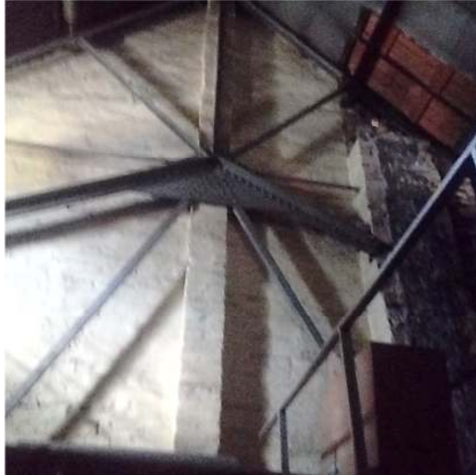
Az irodarészi tető lezárása az áramátalakító felé
