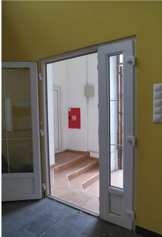
Új belső műanyag nyílászárók, de a homlokzati nyílások eredeti vasszerkezetének rendjét megőrizték
