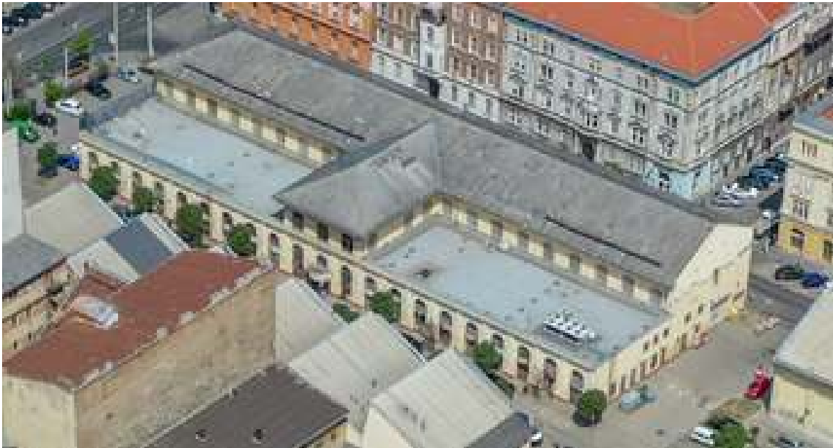
Az épület átalakult tömege – a shed-tető eltűnt, ablakok a volt reníz belső hosszoldalán és középen az új kapcsoló tömeg az emeleten kialakított irodaszint felé
