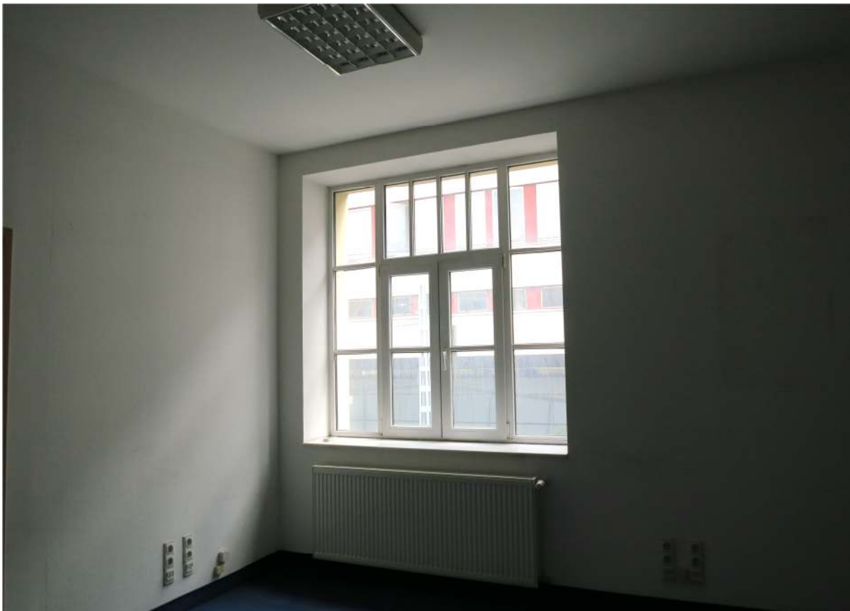
Földszinti ablak-típus a teljes épületen, ill. emeleti ablak a Dembinszky utcai és a vele párhuzamos belső homlokzaton
