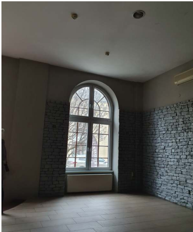
Új belső műanyag nyílászárók, de a homlokzati nyílások eredeti vasszerkezetének rendjét megőrizték
