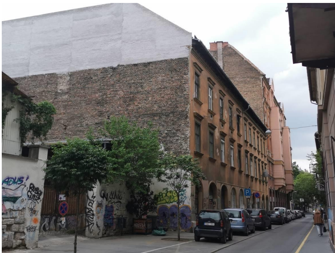
Az épület északnyugat felől nézve.
