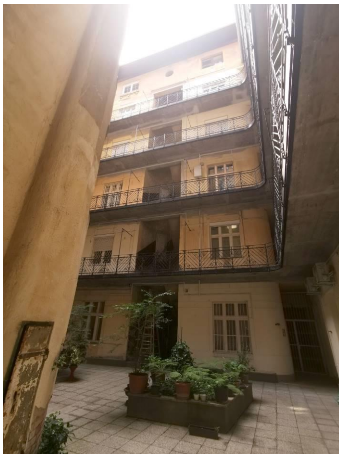
Az épület udvara a bejárat felől.
