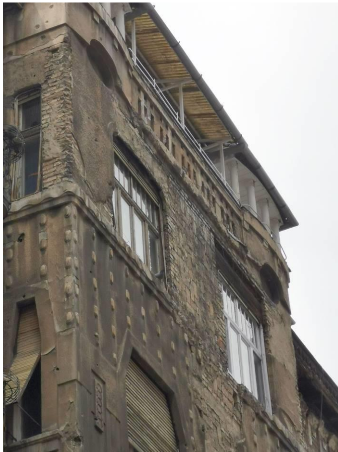
Az épület felső középső részének állapota. A vakolathiányok mögött nincsenek szerkezeti repedések.
