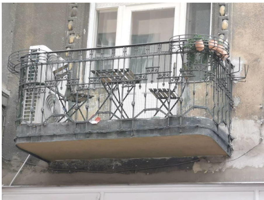
Erkély a homlokzaton.
